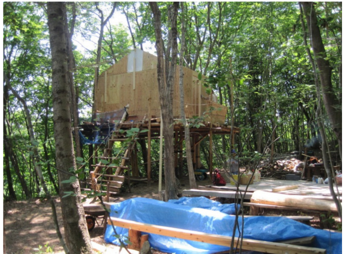
( 建築中のツリーハウス 6月8日撮影 )
